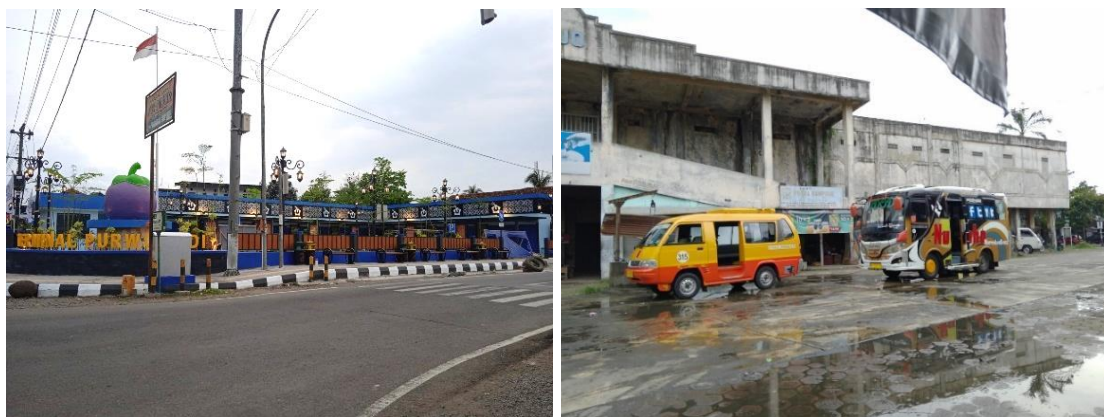
Gambar 2.74. Kondisi Eksisting Terminal Tipe C Purwodadi (kiri) dan Terminal Tipe C Kutoarjo (kanan)
