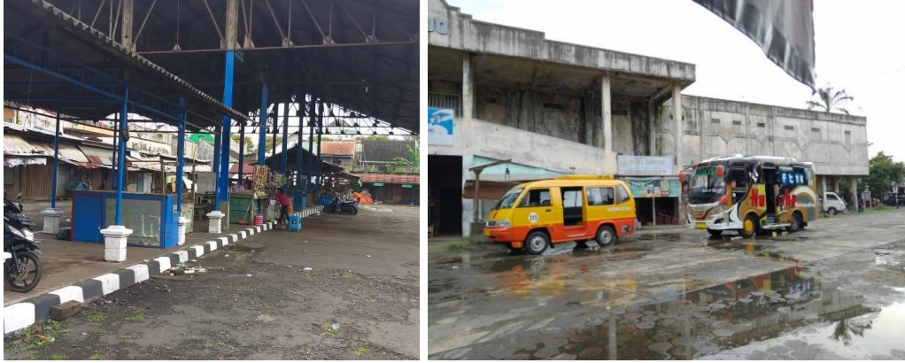
Gambar 2.40 Kondisi Eksisting Terminal Tipe C Kongsis (kiri) dan Terminal Tipe C Kutoarjo (kanan)
