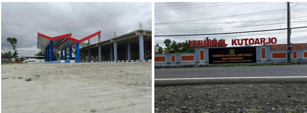
Gambar 2.39 Progres Pembangunan Terminal Tipe B hingga Akhir Tahun 2022
