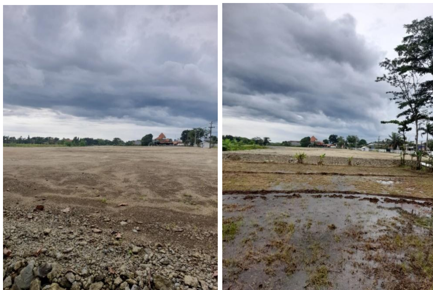
Gambar 2.38 Progres Pembangunan Terminal Tipe A hingga Akhir Tahun 2022
