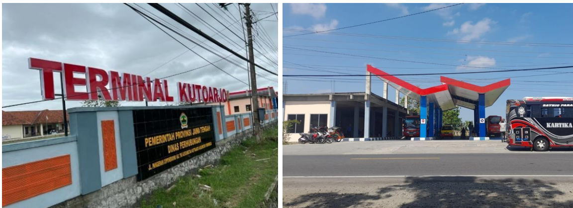
Gambar 2.42. Progres Pembangunan Terminal Tipe B Kutoarjo hingga Akhir Tahun 2023
